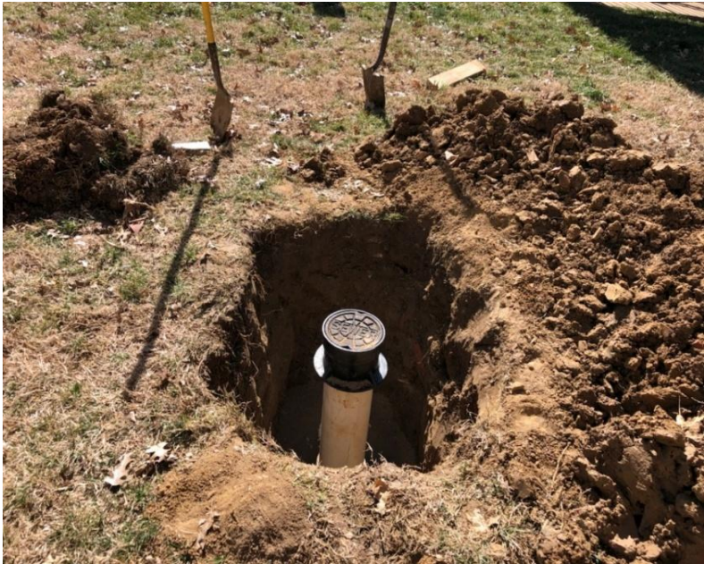
Badenhaus Sewer Repairs
