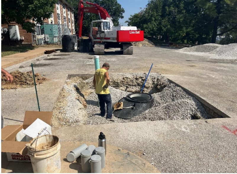
Badenhaus Sewer Repairs
